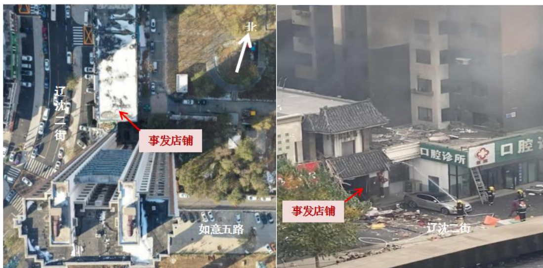
图1 图2 发生事故的卿雅堂推拿馆及周边商铺情况
