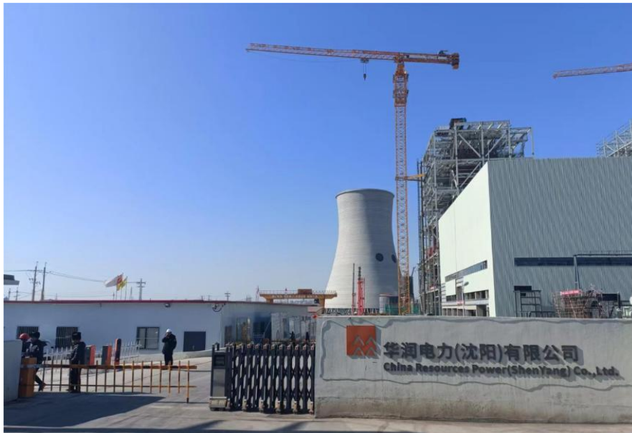
图 1 项目工程施工现场照片
