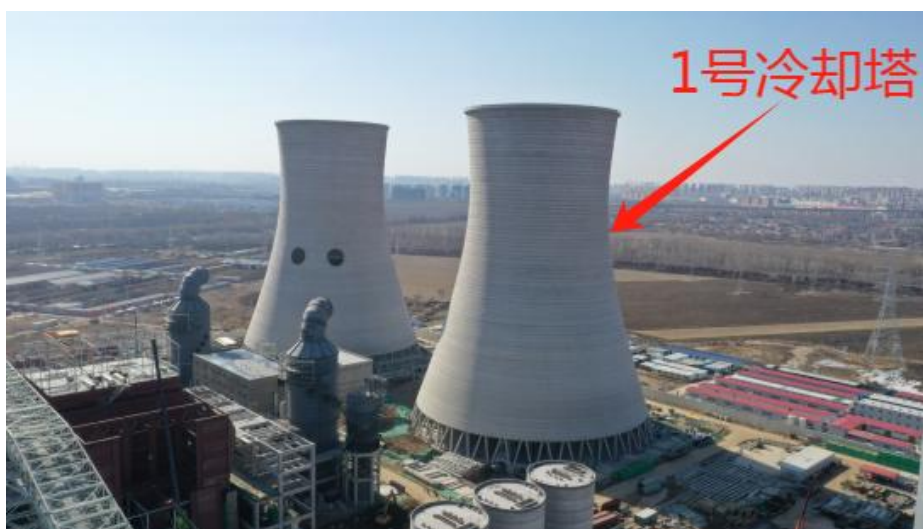
图2 B标段冷却塔
