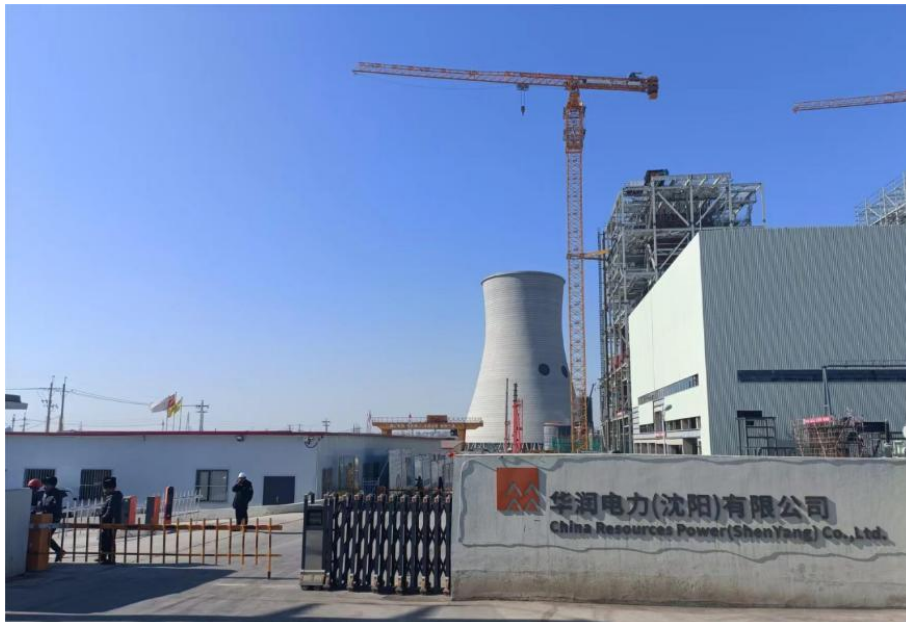
图 1 项目工程施工现场照片
