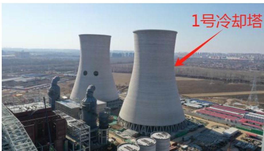
图2 B标段冷却塔
