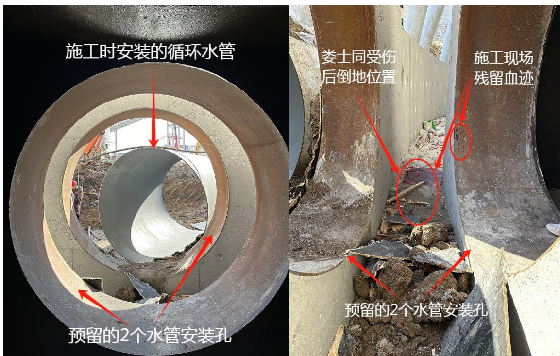
图 4 循环水管安装现场照片 图 5 预留的 2 个安装孔间通道照片
