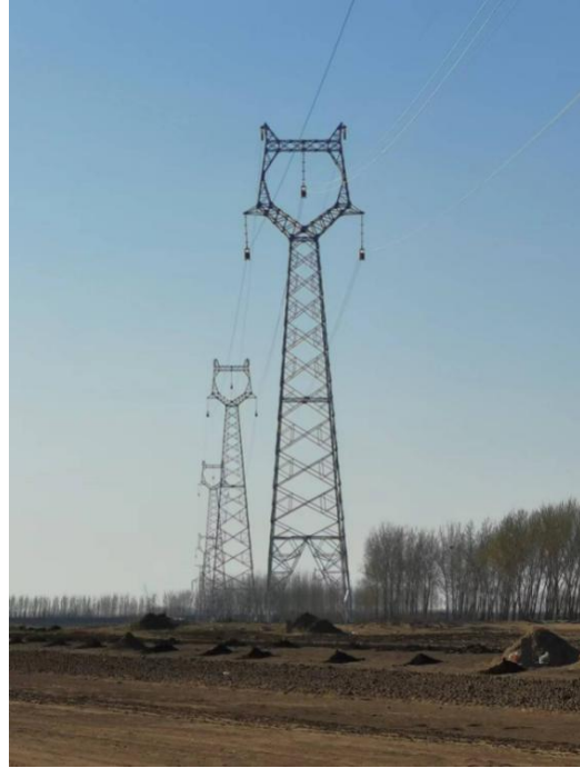
（该工程已建成的铁塔）
