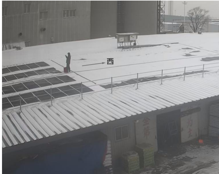
图 4 驻足拍摄光伏设备
