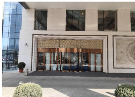
图 2 事故现场勘验照片 2
