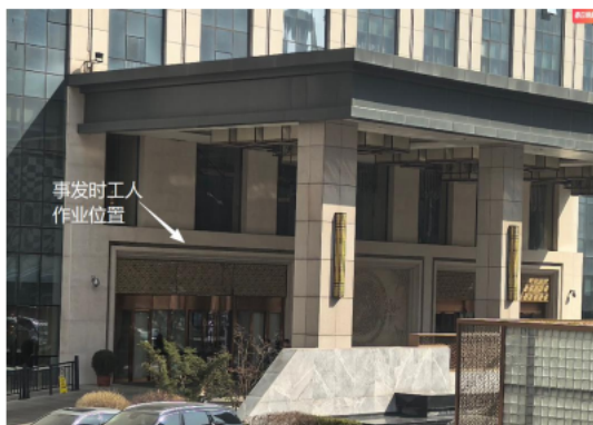
图 1 事故现场勘验照片 1
